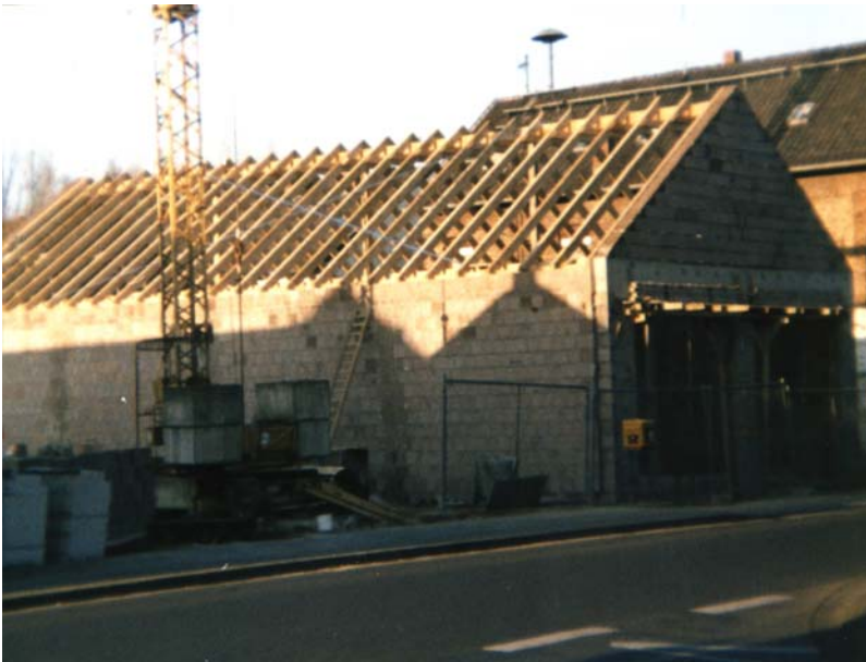
Neubau der Fahrzeughalle 1989
